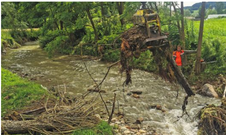
In Richenthal befreit die ZSO Wiggertal den Huebbach von Schwemmh Holz. Fotos zvg
