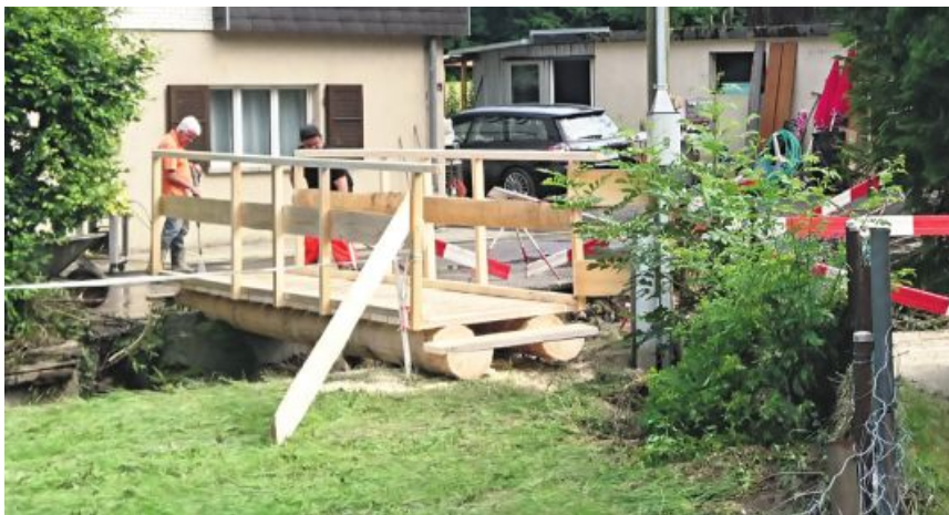
In Langnau errichten Angehörige der ZSO Wiggertal eine Notbrücke.
