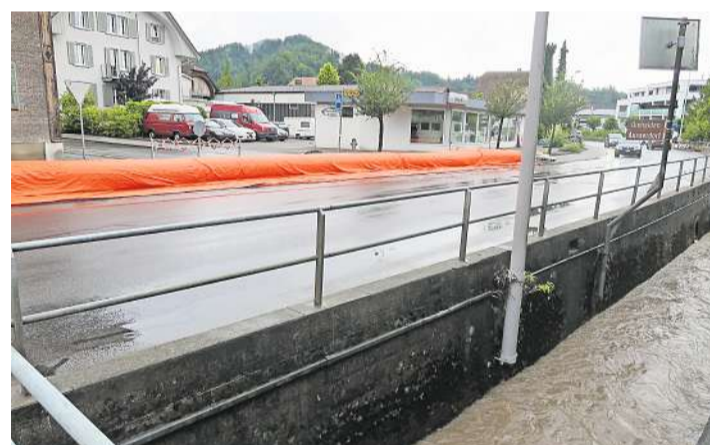
Ein oranger mobiler Deich, vorne der Huebbach gestern Mittag.
