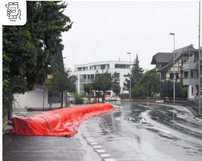
Zwei 40 Meter lange Schutzschläuche der Feuerwehr Zofingen wurden in Langnau gegen den über die Ufer zu treten drohenden Huebbach eingesetzt. – Scannen Sie das Foto mit der Digiplus-App, um weitere Bilder zu sehen. Fotos Emil Stöckli
