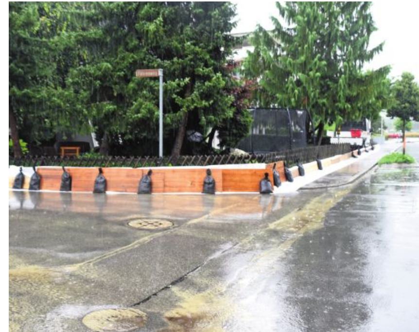
2500 Sandsäcke und mehrere hundert Meter Schaltafeln kamen auf dem Reider Gemeindegebiet im Kampf gegen die Wassermassen zum Einsatz. Im Bild: die verbarrikierte Kreuzung Mattenweg/Föhrenweg in Langnau.
